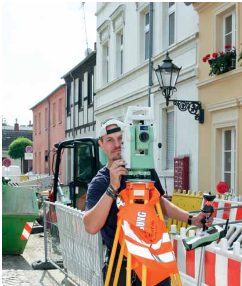
Vermesser Frank Köster vom Vermessungsbüro Kühne begleitet die Tiefbauarbeiten - hier in der Scharländerstraße. Mit dem Tachymeter misst er die Lage der Fernwärmetrasse in ein Koordinatensystem ein und dokumentiert ihre Lage.
