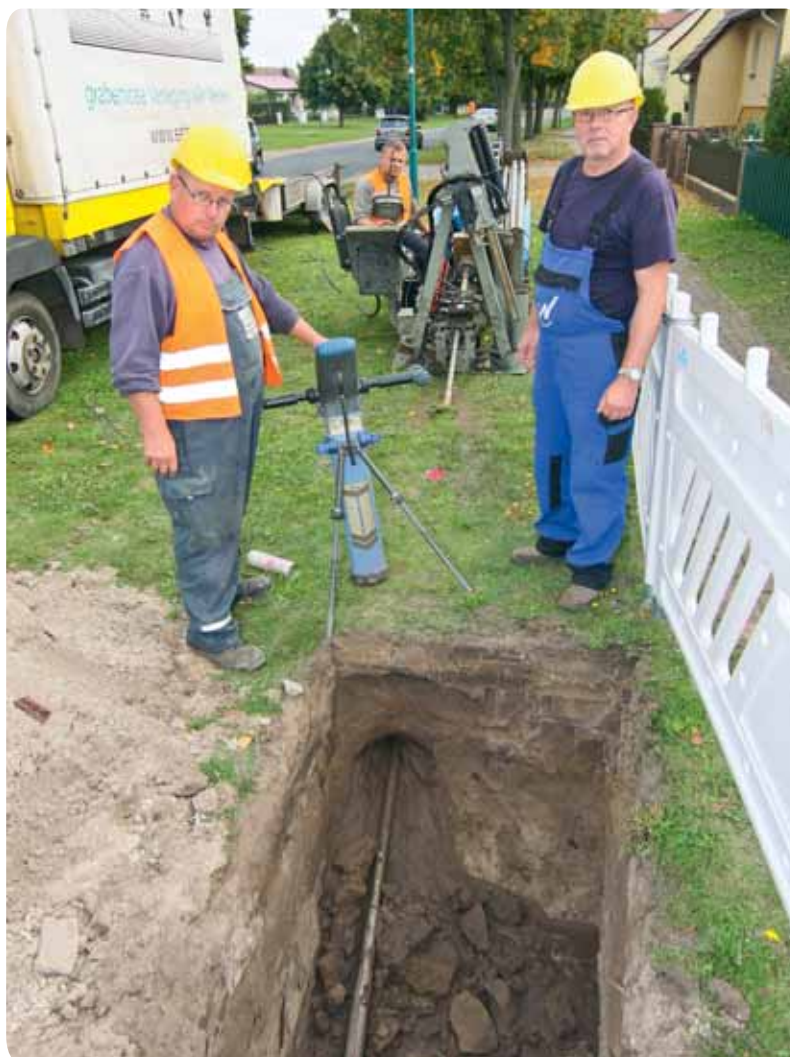
Wurzelschonende Leitungsverlegung im gesteuerten Vortrieb in Nietwerder. Bohrergeräteführer Klaus Niechziol (links) und Maschinist Christian Niechziol von der e.ATN mit Stadtwerke-Netzmonteur Manfred Pause. Er ist Ansprechpartner für die Kunden zu allen technischen Fragen.
