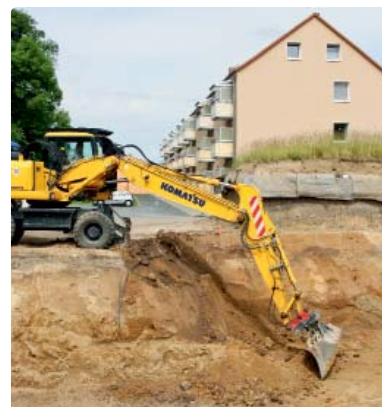
Baugrube für das unterirdische Blockheizkraftwerk am Wasserturm.
