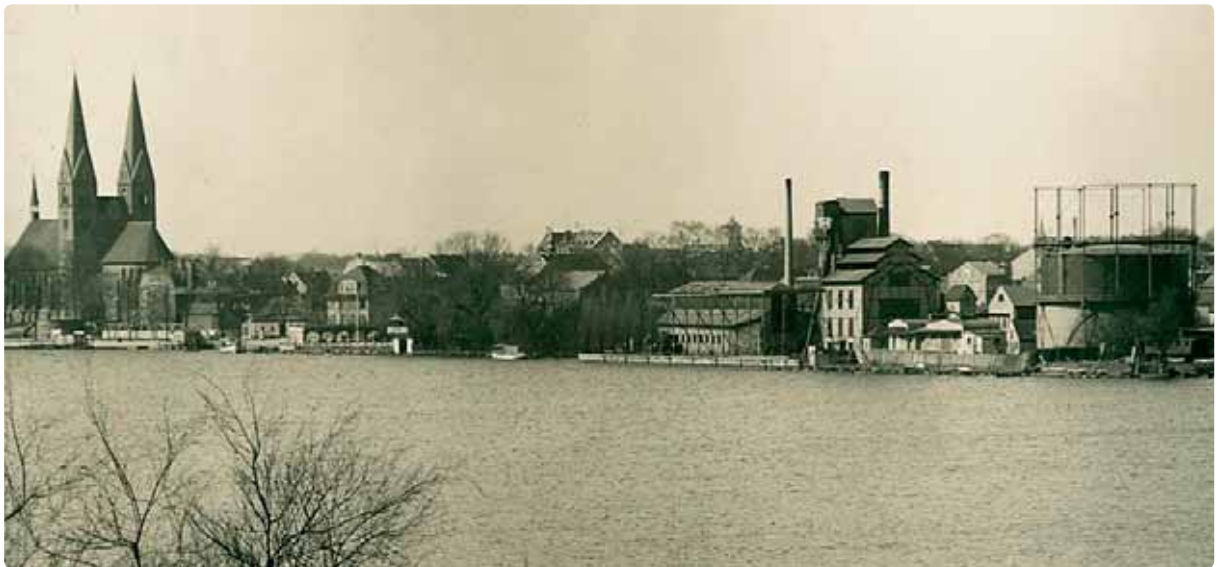
Das Gaswerk von der Seeseite nach dem Neubau zu Beginn der 1920-er Jahre, mit dem großen Gasometer (rechts), dem Ofenhaus mit Schornstein und dem Kohlelager. Davor ist die Bahn der Laufkatze zu sehen. Keine Schönheit am Seeufer, aber für die Kohlelieferung per Schiff war Wasserzugang unbedingt erforderlich. Auch ein eigenes Eisenbahngleis führte zum Gaswerk.
