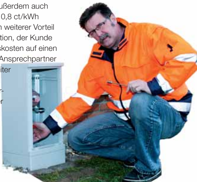
Netzmeister Müller installiert einen Hausanschluss - am Haus, weil kein Keller da ist.
