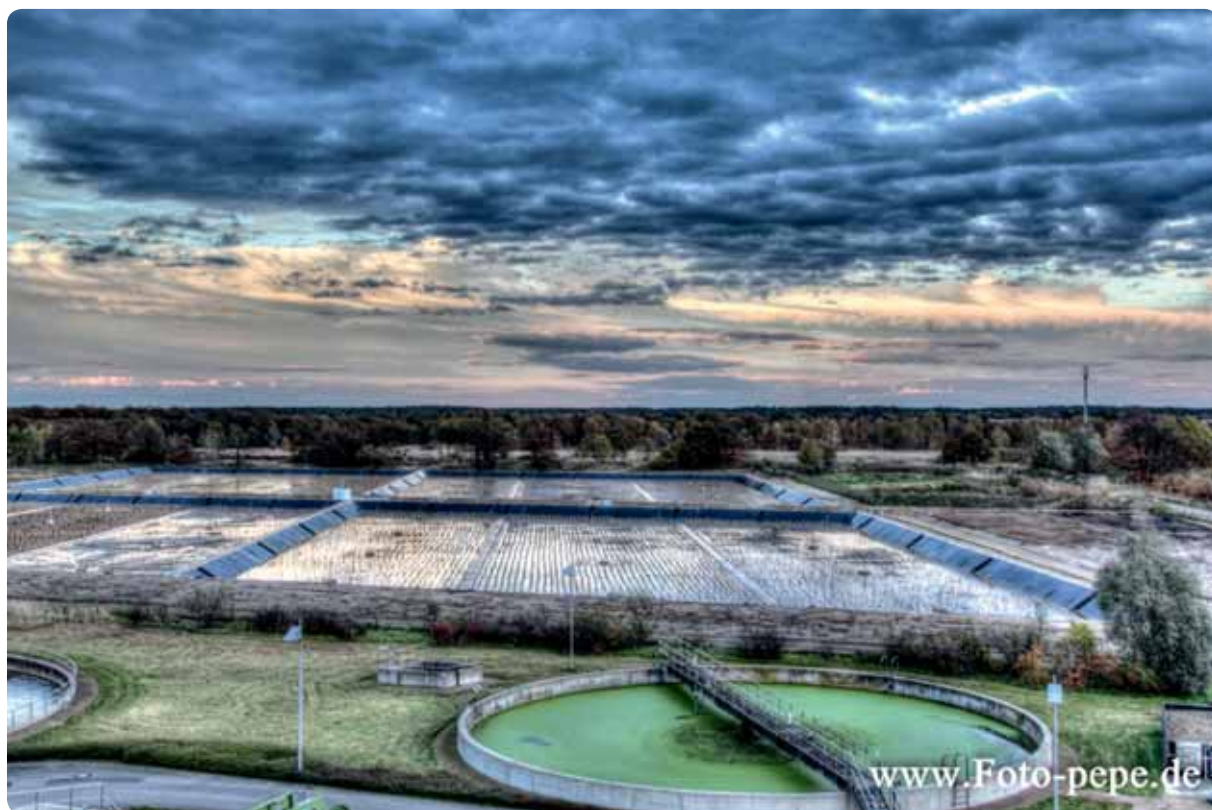
Die Schilfbeete der neuen Veredungsanlage mit den Klärbecken der Stadtwerke im Vordergrund.
