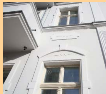
Die frisch geputzte Stuckfassade.
