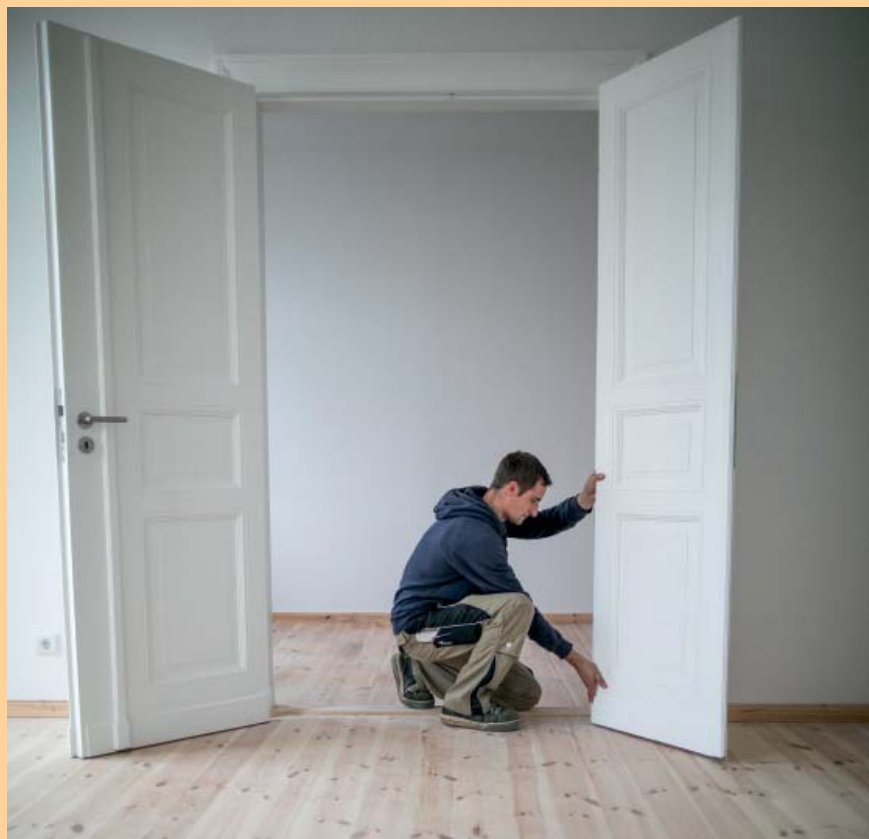
Tischlermeister Chris Helberg setzt die Echtholztüren ein.
