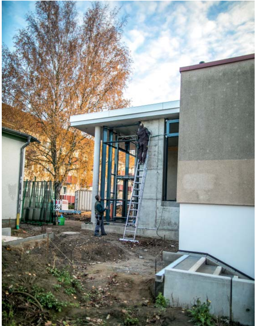
Bauarbeiten am barrierefreien Eingang des WBG-Geschäftshauses.
