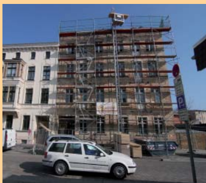
Das eingerüstete Haus.
