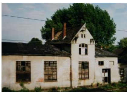
Der Seegarten vor der Sanierung ...
