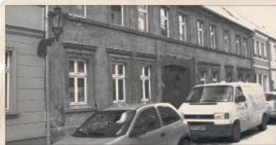
Dieses Haus wird abgerissen und mit originalgetreuer Fassade neu gebaut.
