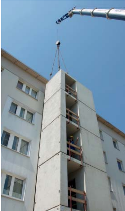
Aufzugschacht aus Fertigelementen.
